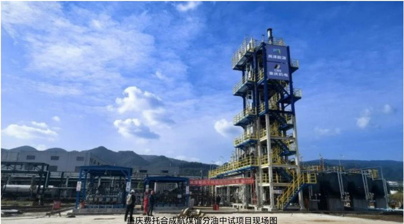
与此同时，岚泽能源千吨级费托合成一步法制航空煤油馏分油柔性中试项目也在紧密推进。该项目坐落于重庆长寿化工园区，采用了自主知识产权、国际首创的一步法合成气制备航空煤油技术，将现有制备路线的3~4步过程缩短为1步，同时具备三大优势：高转化率、高选择性、高稳定性。根据规划进度，项目预计将在2025年5月前全面完成所有测试工作，届时将形成一套具备工业化规模的成套工程技术方案。
