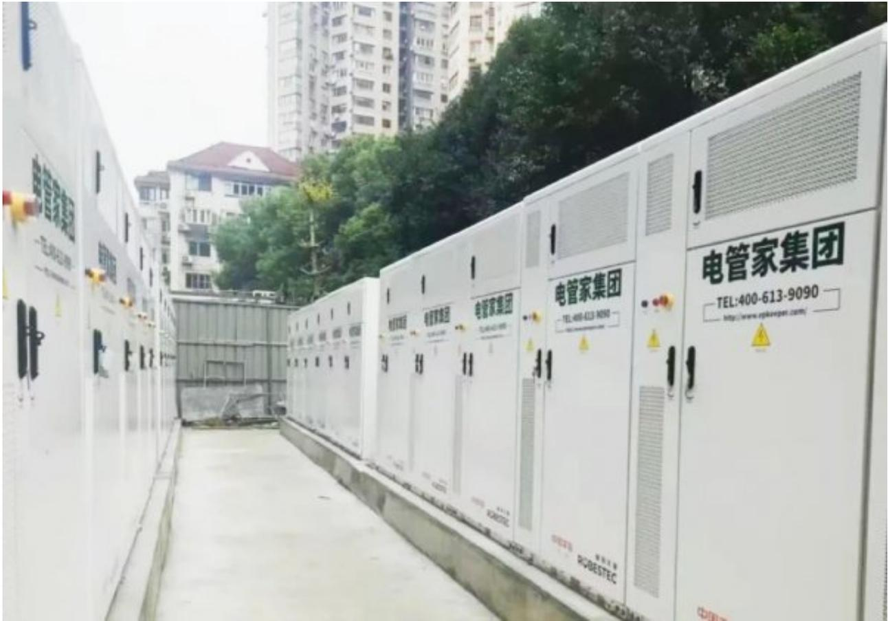
电管家集团作为虚拟电厂负荷聚合商，长宁国际 3000kW/6000kWh 储能项目的建成为虚拟电厂建设再添可控负荷。该项目接入电管家集团自主研发的“法拉第”综合能源管理平台后，将通过其中的虚拟电厂管理平台集中管控调度，让用户侧与大电网之间达成互动，参与调峰调频，优化电力资源配置，实现区域所需的电力交易及供能需求响应，助力新型电力系统构建。
