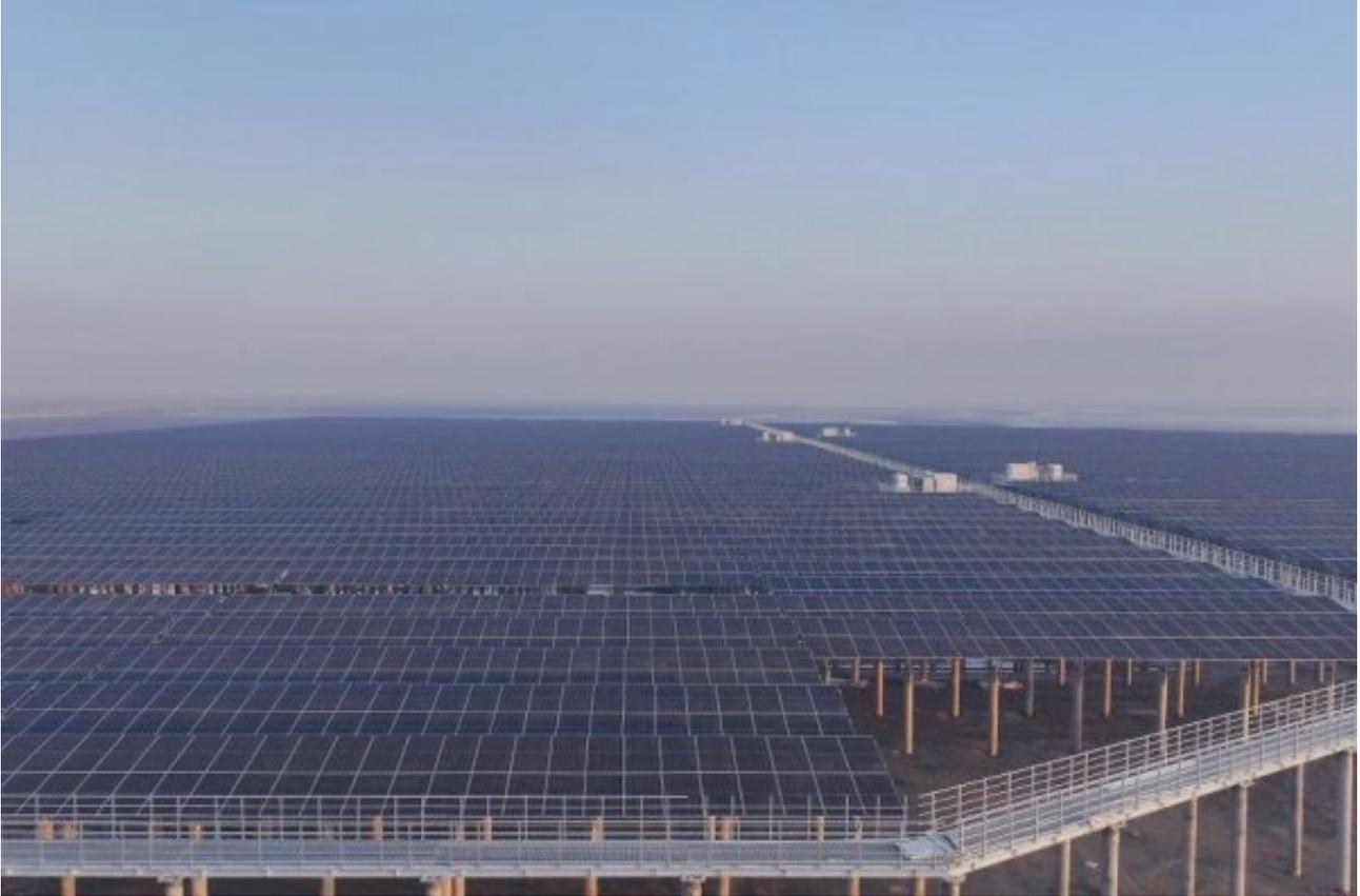
如东“光氢储一体化”项目是国家第三批“沙戈荒大风电光伏大基地项目”。项目地处江苏省如东县豫东垦区堤外滩涂，总装机400兆瓦，占地4300亩，新建一座220千伏岸基升压站，安装60兆瓦/120兆瓦时储能站和一座制氢能力1500标方/小时、加氢能力500公斤/天的制氢加氢站。项目建成投产后，年平均上网电量约4.68亿千瓦时，每年可节约标煤约15.1万吨，每年可减少排放二氧化碳约30.94万吨、二氧化硫约562.6吨、二氧化氮约1125.3吨，助力了地方生态环境保护和绿色低碳发展。
